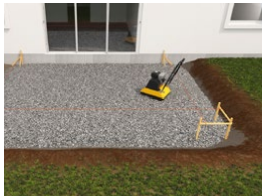
Lägg ut makadam, packa med vibratorplatta och väg av.
