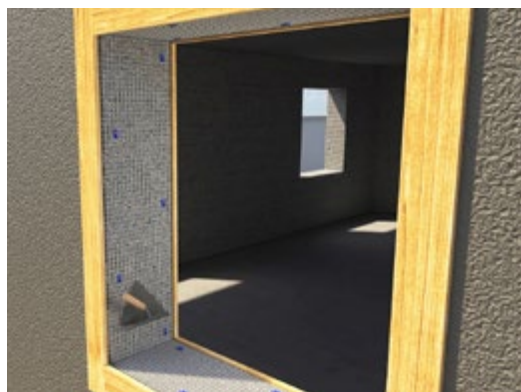
Tryck fast läkt i bruk runt öppningar som stöd för rätskivan i smygar.
