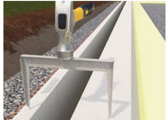
Fäst med breda fixeringskilar mellan de vertikala delarna.
