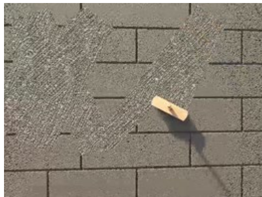
För att säkra att hela väggen täckts av Grundningsbruk A borstar man ytan med en kalkkvast.
