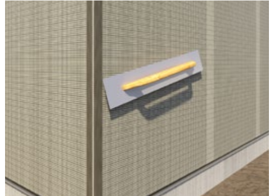
Fäst glasfibervinklar i hörn genom att trycka fast dem i bruk.
